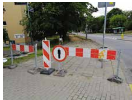
Przebudowa chodnika przy ul. gen. Maczka
