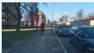
Nr 1 Budowa ciągu pieszo – rowerowego w ul. Piątkowskiej na odcinku do Al. Solidarności w kierunku ul. Szydłowskiej, strona zachodnia.
