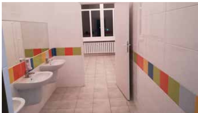
Wyremontowana toaleta w SP 27
